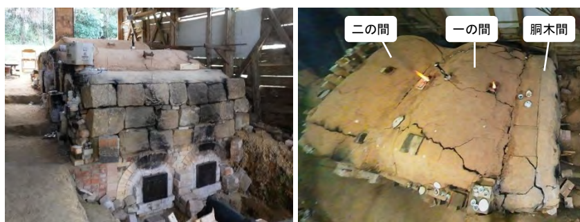
図 2 窯本体の外観 左:正面 右:上面
