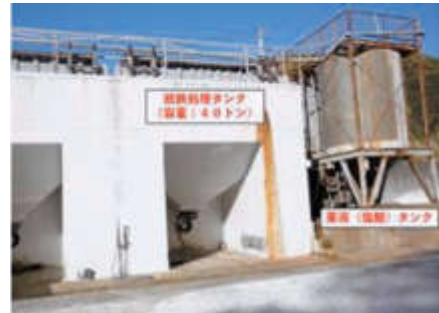
図3 塩酸脱鉄プラント(木山陶石鉱業所)
