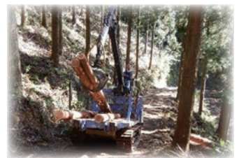
森林作業道を利用した運材作業
