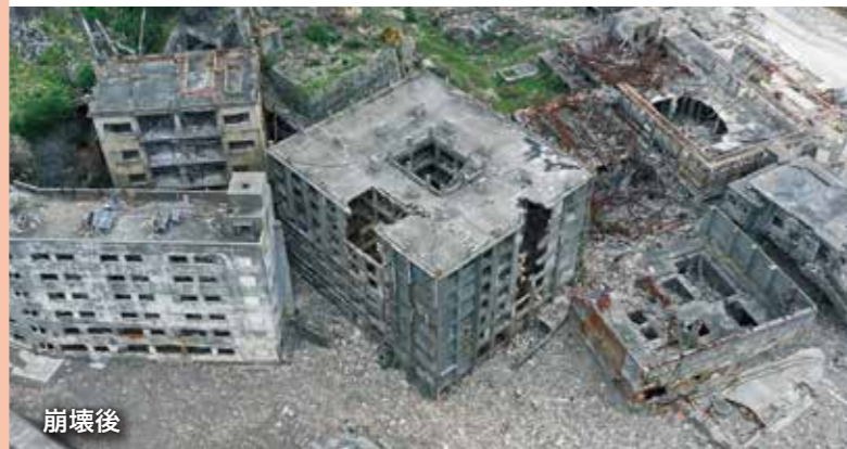
写真4 崩壊が進む30号棟
