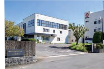
約1万3千㎡の敷地内に物流棟を増設中
