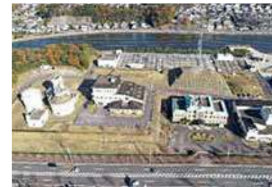
大村湾南部浄化センター
