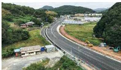
国道202号 浦頭拡幅
