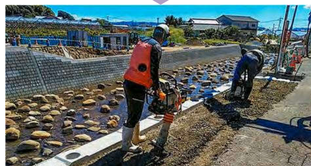
⑦ 下層路盤・上層路盤（敷均し・締固め）
