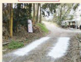
タイヤ全周が消毒できるように 消石灰を縦に散布
