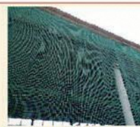
堆肥舎のレール式防鳥ネット (レール部分は2重に設置)
