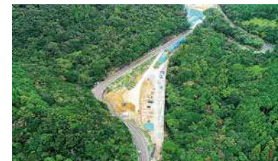
国道384号道路改良工事（白魚バイパス）
