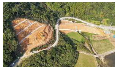
主要地方道玉之浦大室線道路改良工事（立谷工区）
