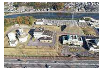
大村湾南部浄化センター
