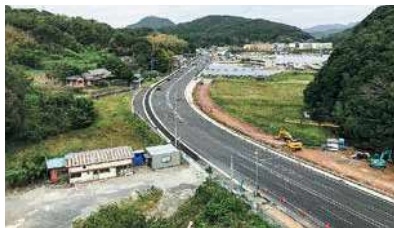
国道202号 浦頭拡幅
