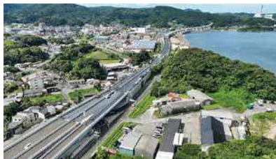
西九州自動車道 松浦佐々道路
