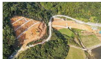
主要地方道玉之浦大宝線道路改良工事（立谷工区）
