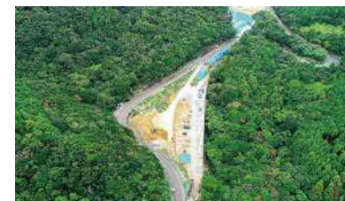
国道384号道路改良工事（白魚バイパス）
