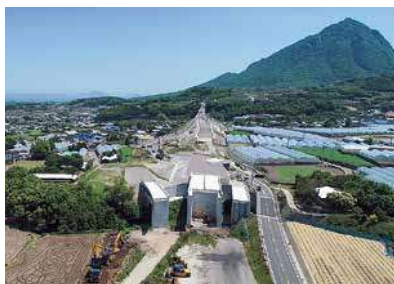
島原道路(出平有明バイパス)
