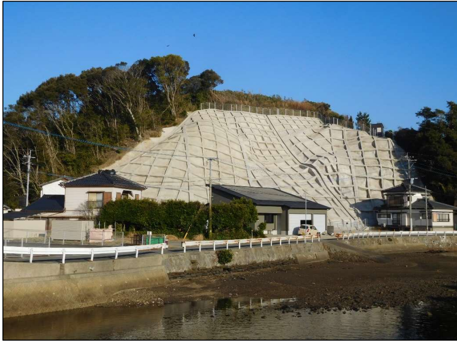
写真-1 1期工事箇所(令和7年9月完成)
