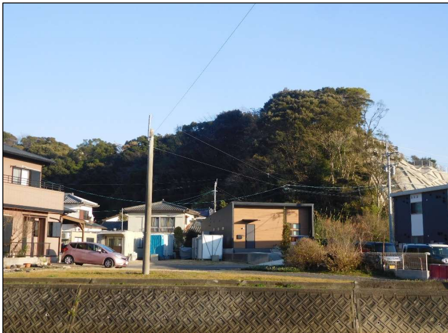
写真-2 2期工事箇所
