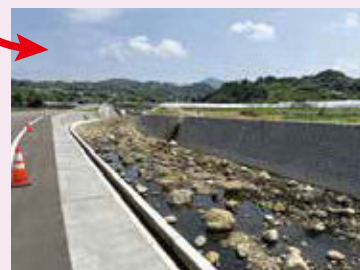
佐奈河内川(復旧後)
