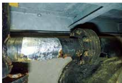
放流バルブ（漏水による応急補修）
