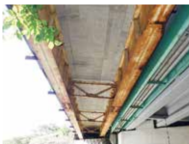
橋梁補修の事例【対策前（腐食）】
