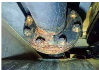
放流バルブ（発錆等による老朽化）
