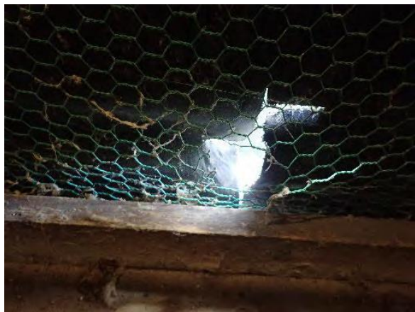
鶏舎の金網の破損
