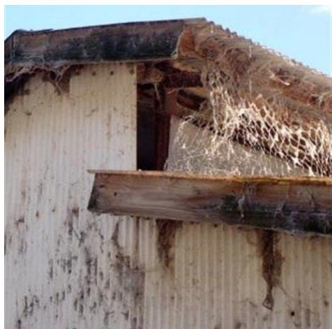
防鳥ネットの破れと鶏舎の壁の破損
