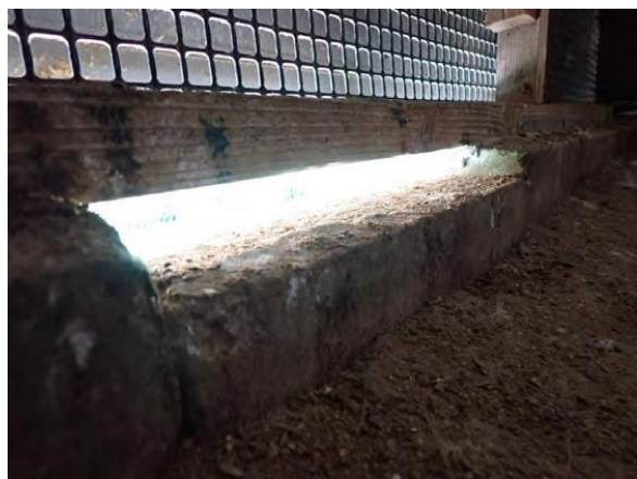
鶏舎排水口の閉鎖不全による隙間
