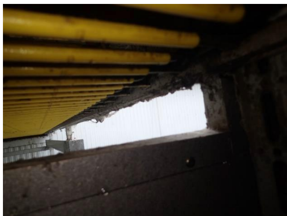
鶏舎の金網の破損
