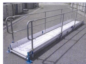
アルミ製仮設通路の設置
