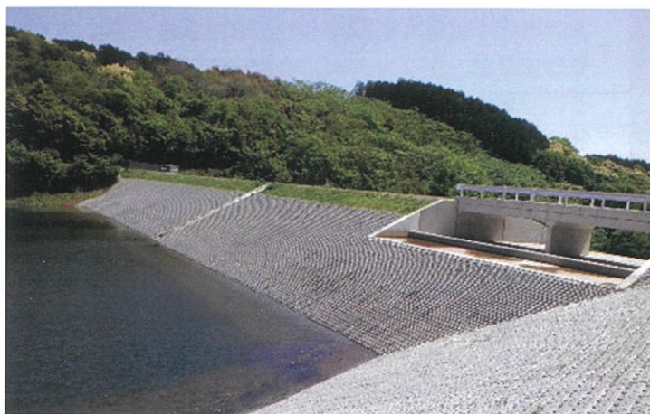
令和6年度完成 赤似田ため池（大村市）
