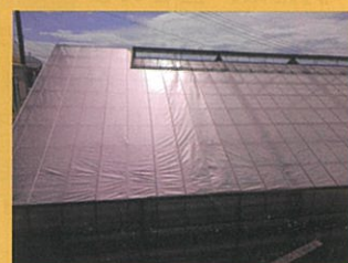
塗布後の様子
