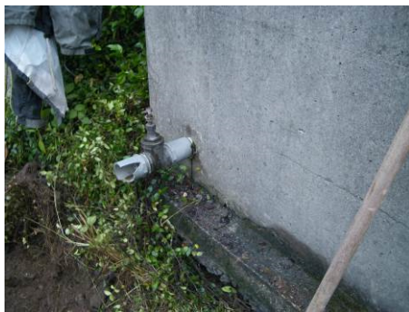
．防油堤のひび割れとバルブ
