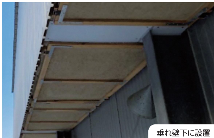
●レイヤー農場のWL鶏舎でのエアフィルター使用事例
