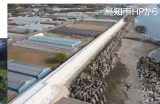
高知市HPから 海岸堤防整備
