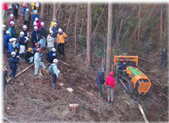
林床整理伐・地拵え作業実証試験（デモ）
