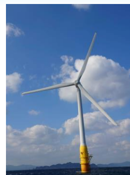
五島市沖2MW洋上風車
