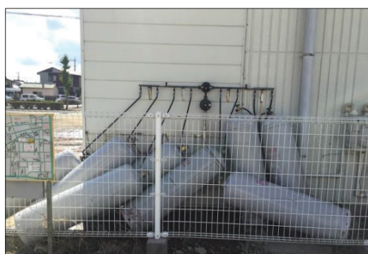
濁流により流出寸前の容器
