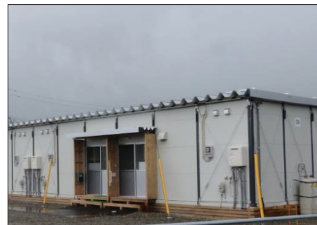
仮設住宅の建設
