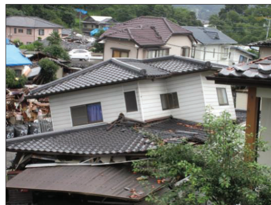
倒壊した住宅（益城町）
