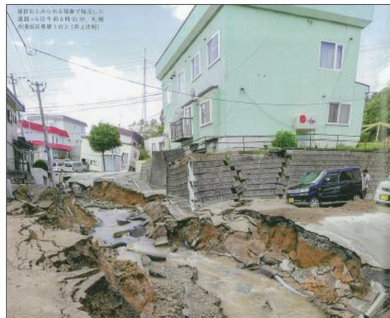
液状化により地盤沈下が発生
