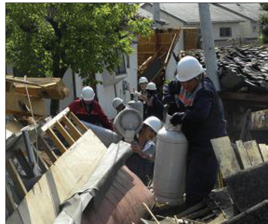
瓦礫の中から LP ガス容器を撤去
