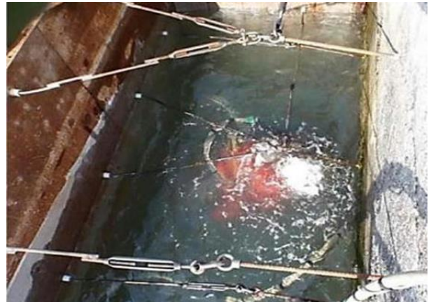
写真 4 セパレーター溶接状況
