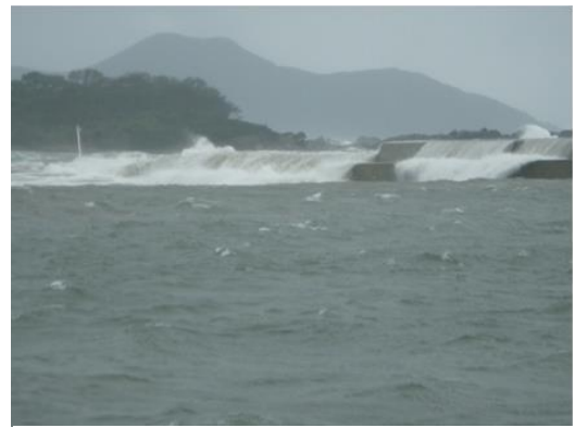
写真2 沖防波堤被災状況(2)
