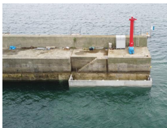
写真 9 オール残置型枠化施工状況
