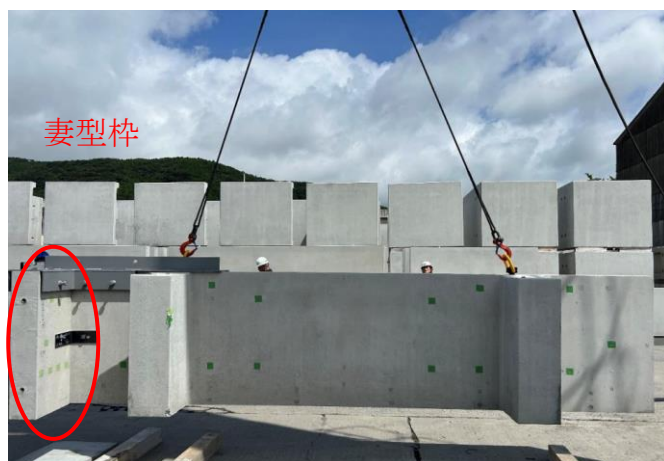
写真 8 妻型枠の残置型枠化
