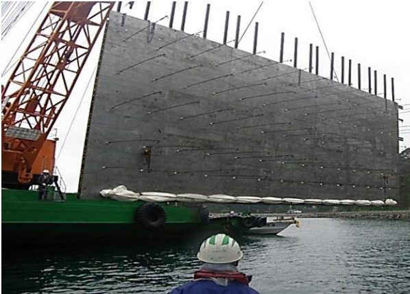
写真 3 鋼製型枠施工状況
