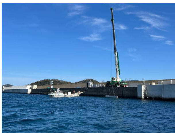
写真 7 陸上機械による残置型枠施工状況
