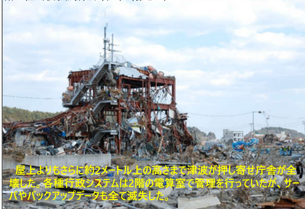
南三陸町防災対策庁舎（3階建て）
