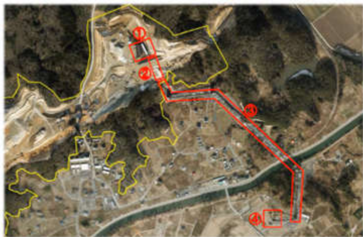
ベルトコンベアー全景【2014(平成26)年1月～同10月稼働】
