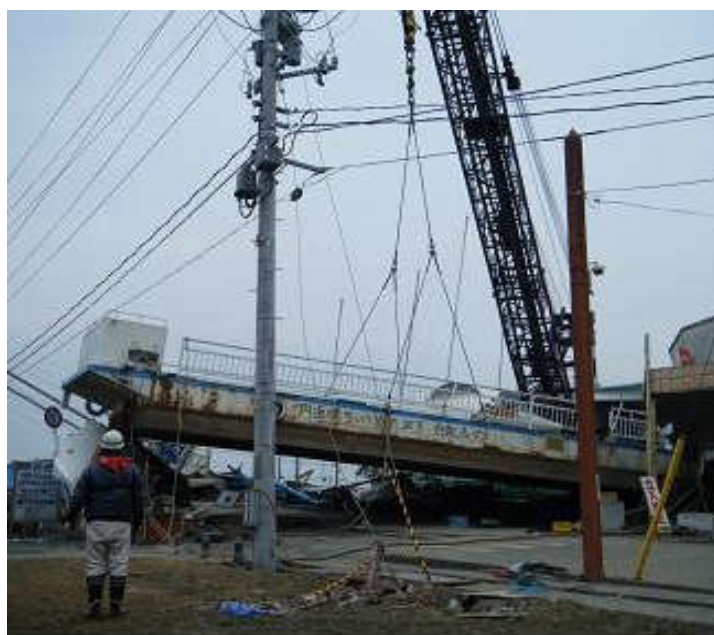
がれきの山を取り除く作業 (国道398号 女川町)
