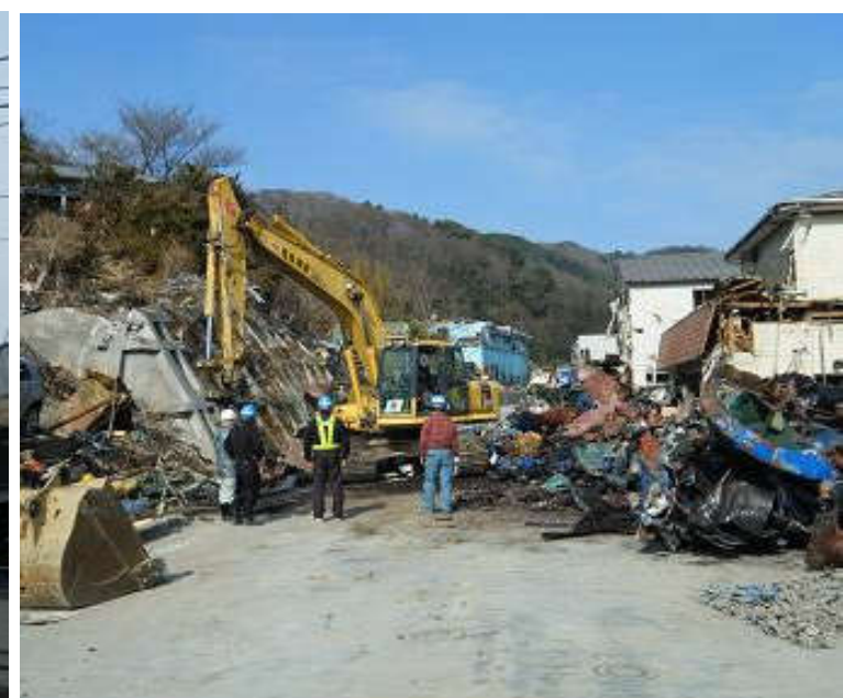
浮き栈橋が乗り上げ国道を寸断 (石巻市 国道398号 内海橋)
