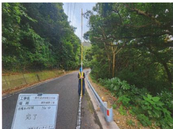
図-4 伐採直後の様子
