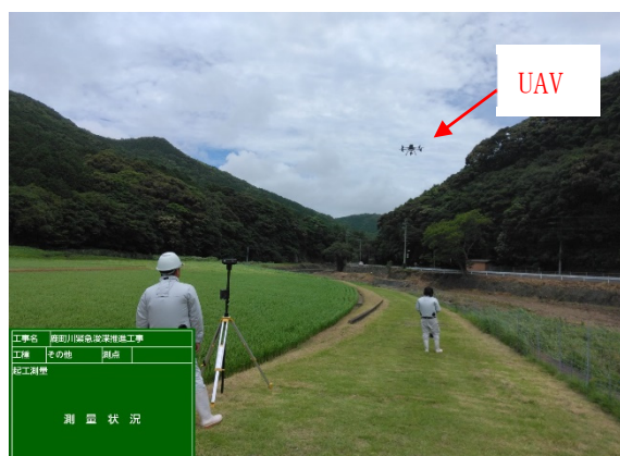
写真2 3次元起工測量状況
