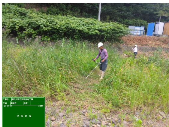
写真1 着工測量前伐採状況
