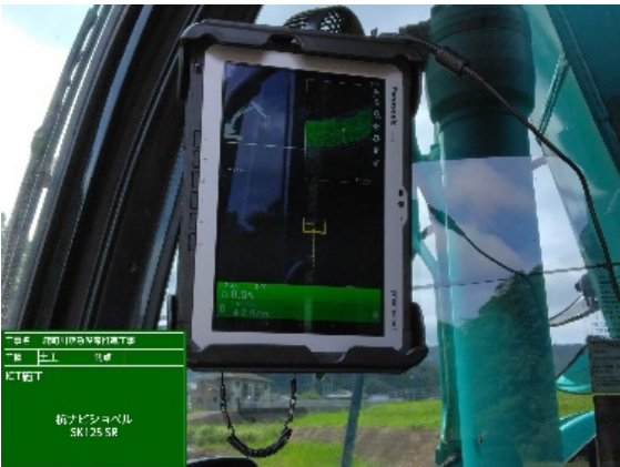
写真4 ICT 建設機械のモニターの状況
