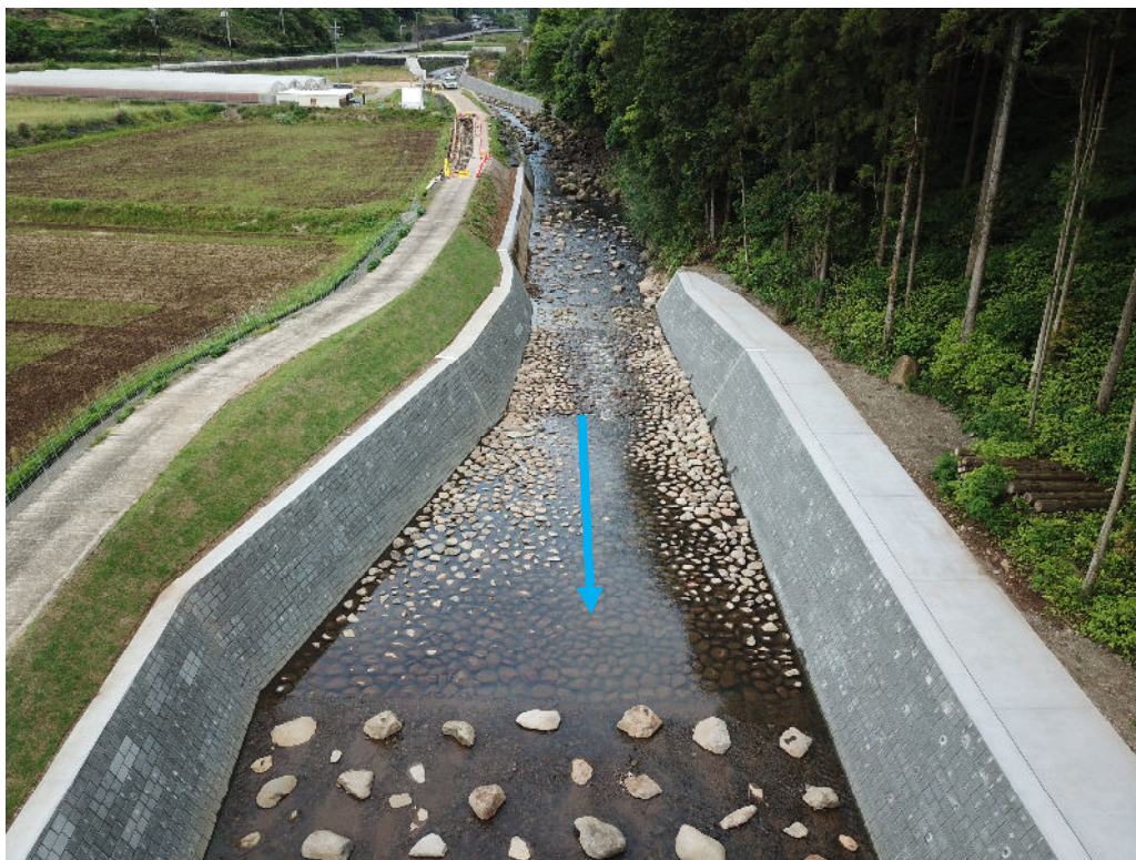
写真－3 佐奈河内川 落差工竣工写真
