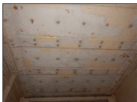
写-5 床版下面の様子
