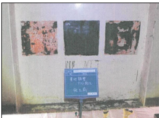
写-4 試験施工の様子
