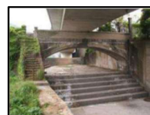
写真-14 本河内低部ダム日本最古のRC橋
