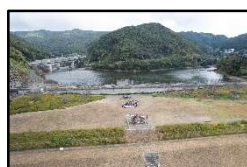
写真-13 本河内高部ダム
