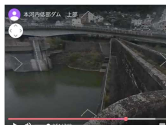
写真-8 本河内低部ダム
