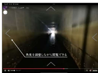
写真-7 中島川パイパス水路
