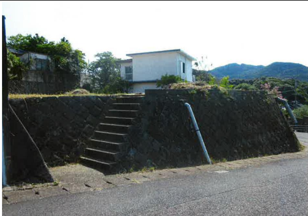
北東側より撮影
