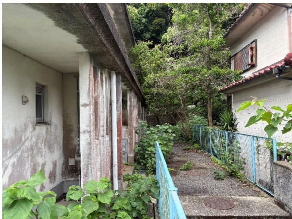
南東側より撮影
