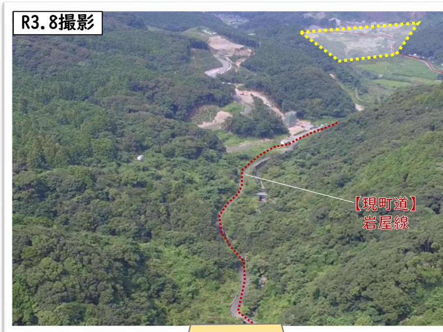
写真⑤ 上流部～中流部(3号橋周辺)
