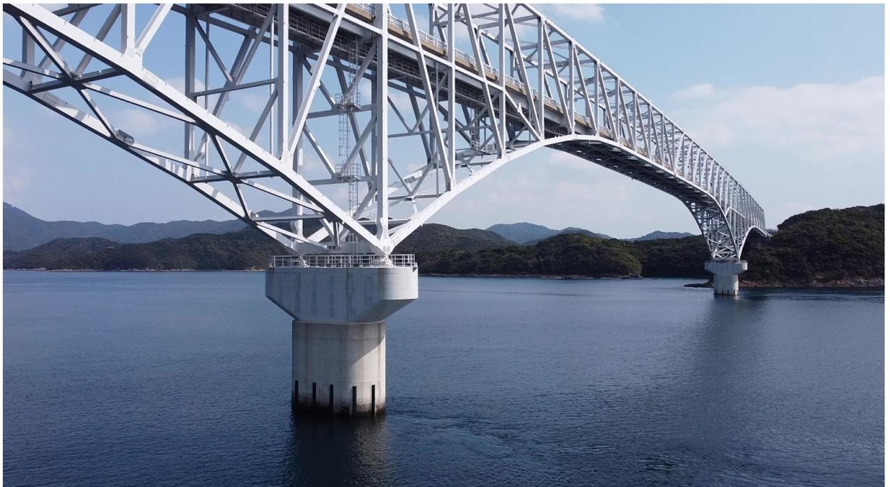
(主)若松白魚線橋梁補修工事(若松大橋P1・P2橋脚補強)完成写真 R7.3
