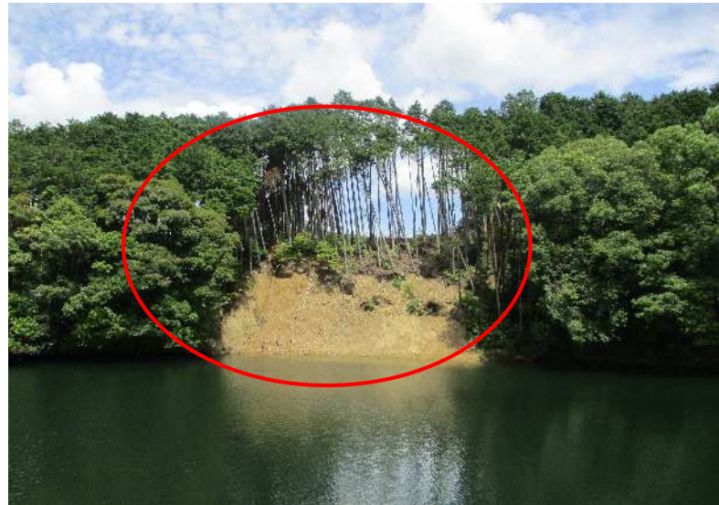
ため池周辺の法面崩壊
