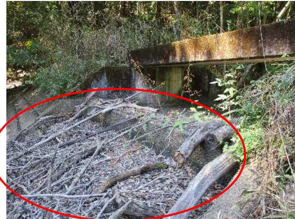
洪水吐流入部の流木の堆積
