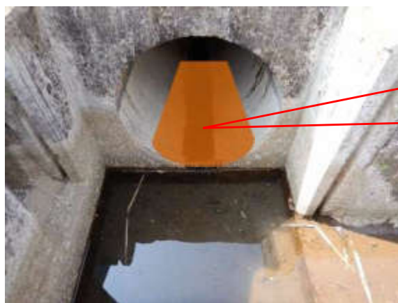
⑰底樋出口の状況
