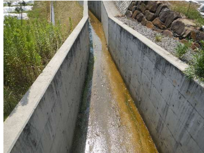
洪水吐（下流側）
