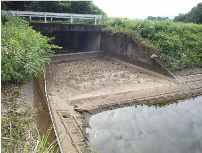
洪水吐（上流側）
