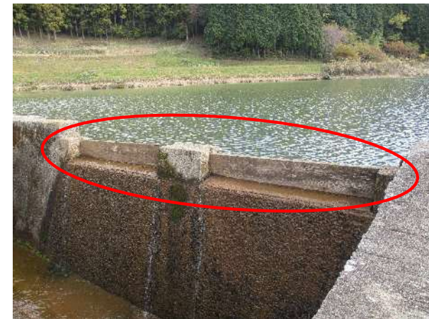
堰板によるかさ上げ
