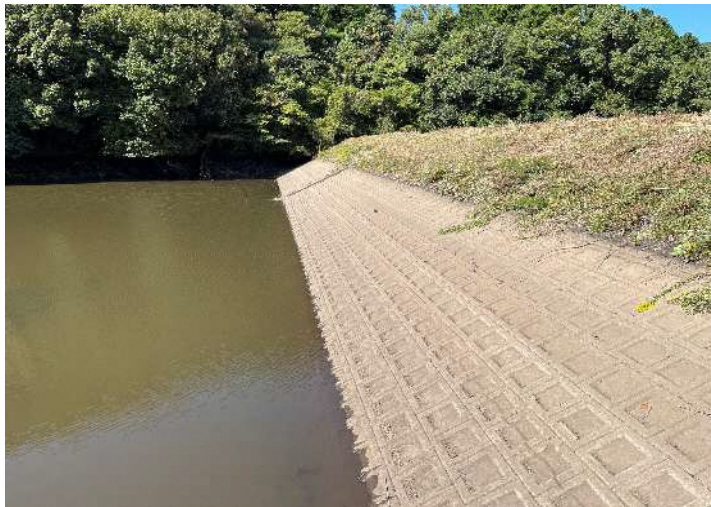
張りブロック
