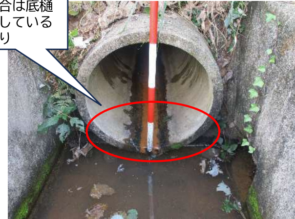
底樋出口（コンクリート管）
