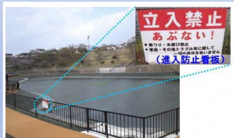
安全柵の設置
