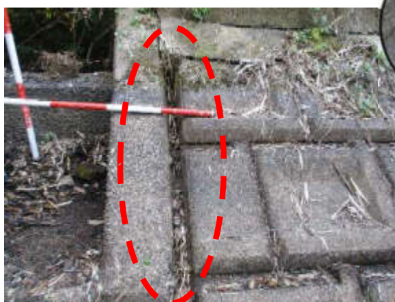
⑪洪水吐と張りブロックの開き
