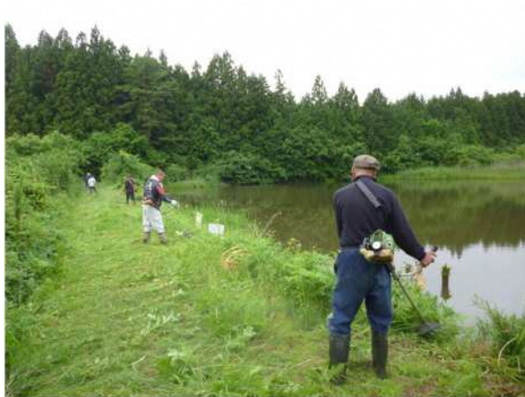
堤体の草刈り
