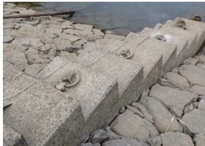
ため池栓（取水栓）
