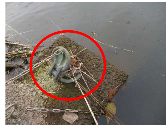
⑩落葉等による取水栓の閉塞
