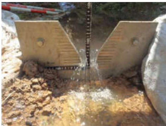
⑫三角堰による漏水量の計測事例
