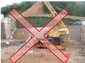
排ガス・低騒音機械確認写真
