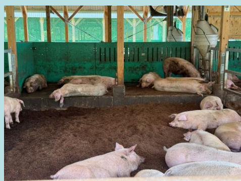
畜産クラスター構築事業を活用した 豚舎整備
