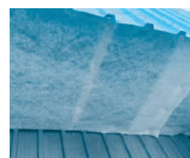
鶏舎入気口の フィルター設置
