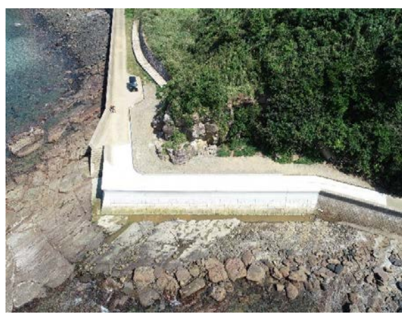
復旧完了(農地海岸) 令和3年度災害(松浦市)
