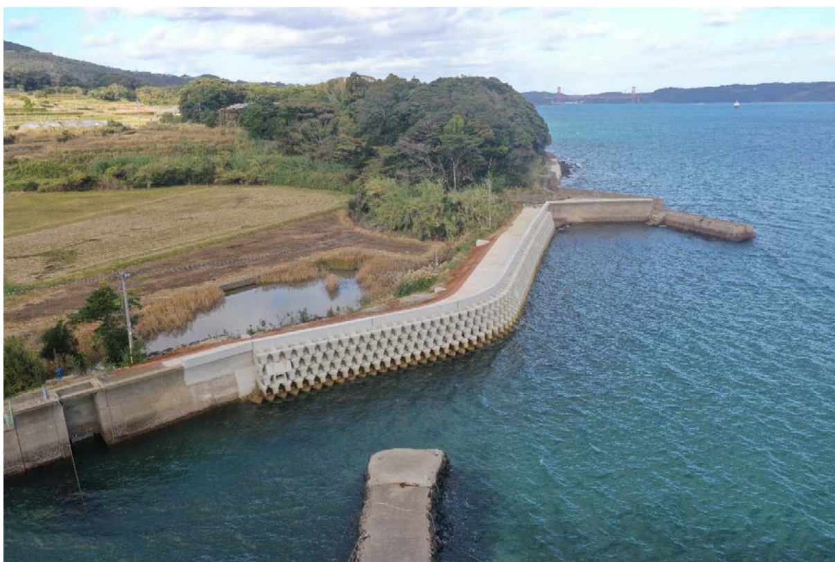
大崎地区の護岸工 (平戸市)
