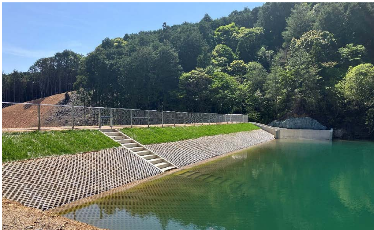
五島地区 津木ため池（五島市）
