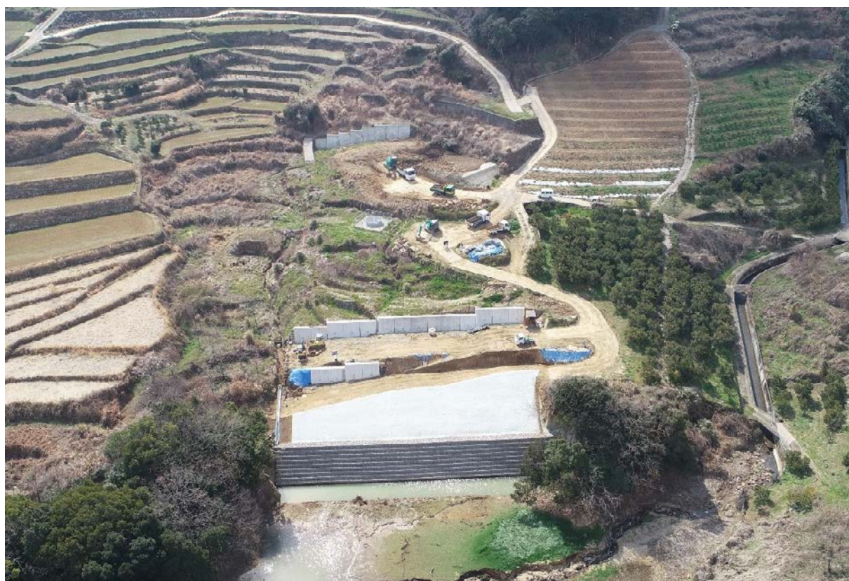
座木地区の抑止工、抑制工(南島原市)
