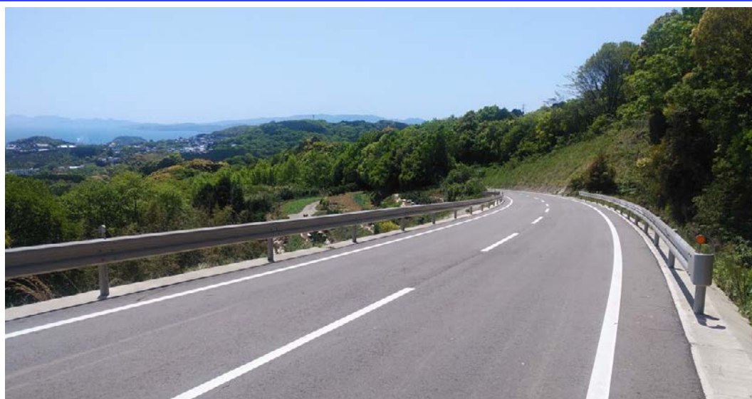
川棚西部地区(H22～実施中)
