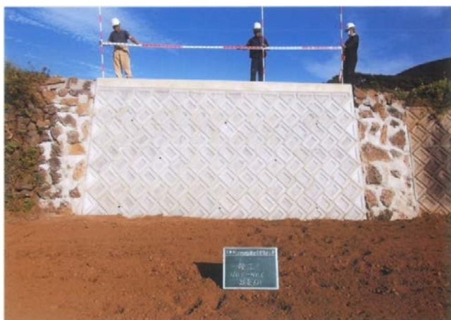
復旧完了(農地) 令和3年度災害(五島市)
