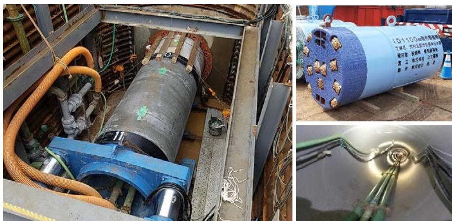
大村北部地区 重井田水路トンネル(大村市) 推進工法
