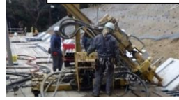
アンカー工事-厳原町久根
