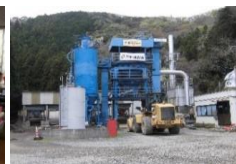
②アスファルト合材工場
