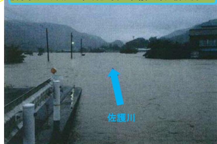
浸水状況（平成22年7月洪水）：佐護川深山橋下流
