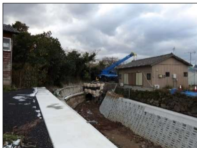
No.920付近 施工状況
