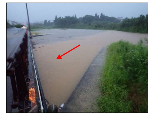
令和6年7月14日豪雨による被害状況
