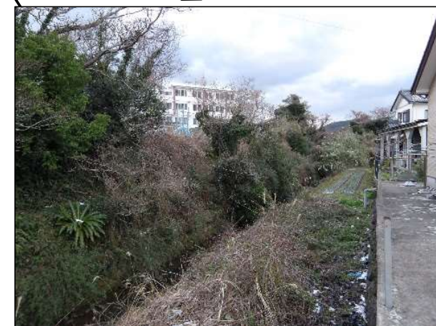
No.960付近 未整備箇所
