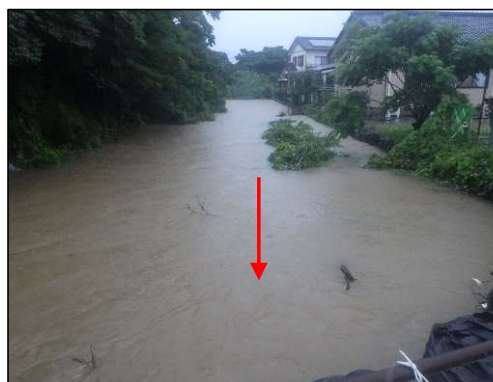
令和6年7月14日豪雨による被害状況
