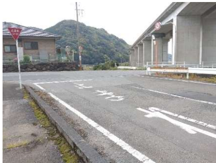
国道34号との交差点状況
