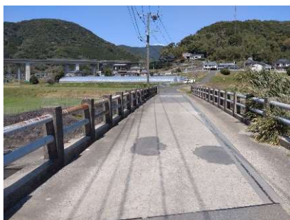
①町道白丸線(国道34号を望んで撮影)
