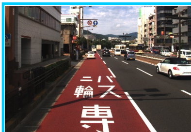
【健全度Aの状況】 舗装が新しく望ましい状態
