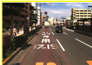
【健全度Bの状況】 舗装は新しくないが望ましい状態
