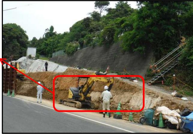
写真1 斜面崩壊による地層のズレ
