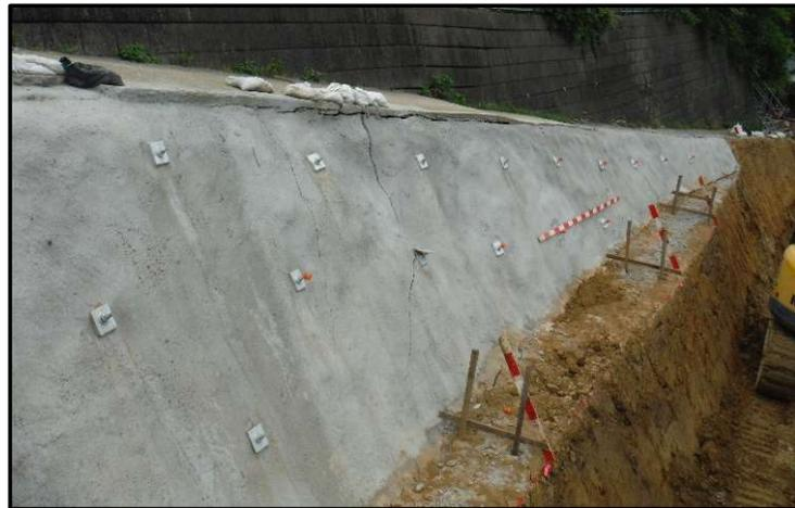
写真2 モルタル吹付のひび割れ(床掘り面)
